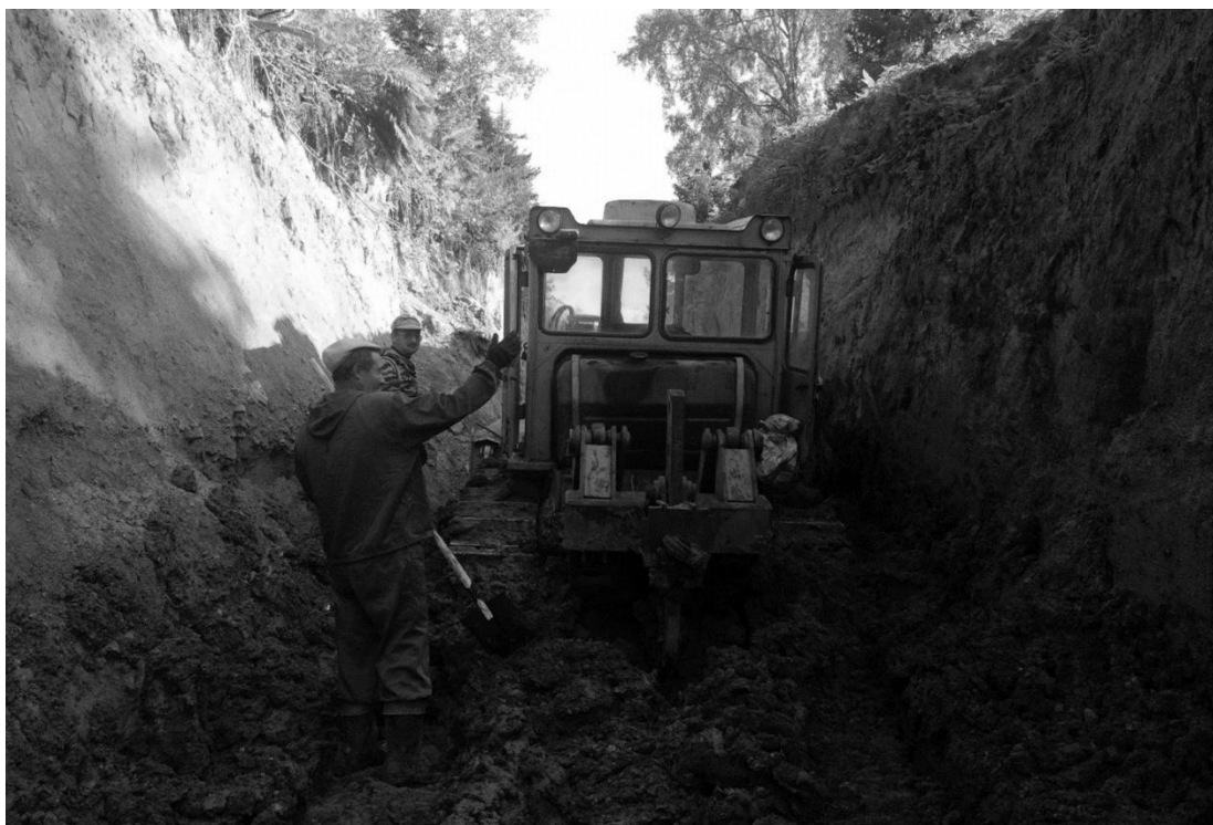
Рисунок – Канавы № 15 бульдозерной проходки
