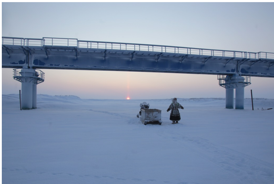
Рис. 2. Тундровая дорога под мостом. Ямальский район, январь 2016.
