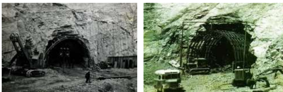
Рис. 3.1. Строительство железнорогского Горно-химического комбината. Источник: пресс-служба ФГУП «ГУССТ № 9 при Спецстрое России»
