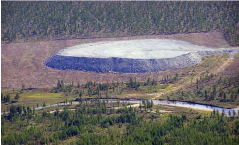
Рис. 3.17. Глыбово-щебнистая насыпь, перекрывающая навал, возникший на эпицентре взрыва «Кристалл». Подъездная дорога примыкает к южной стороне насыпи. На переднем плане ручей Улахан-Бысыттах. Фотография сделана с вертолѐта в 2007 г. (автор Захаров В. Е.)
