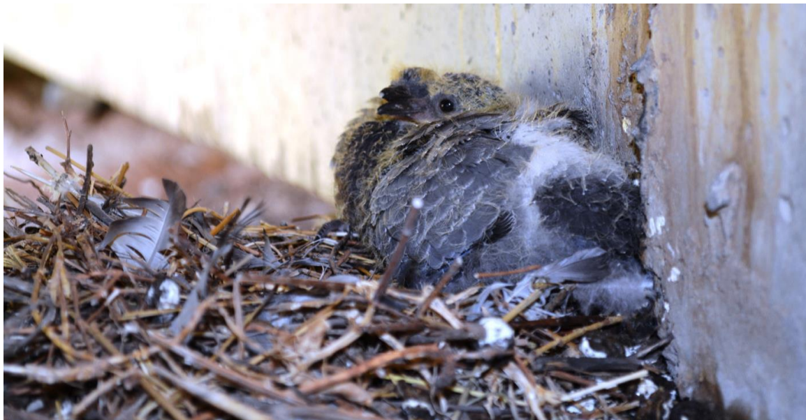
Рис. 9. Гнездо с птенцами скального голубя Columba rupestris на опоре железобетонного моста. 3 мая 2015. Фото А.А.Ластухина.
