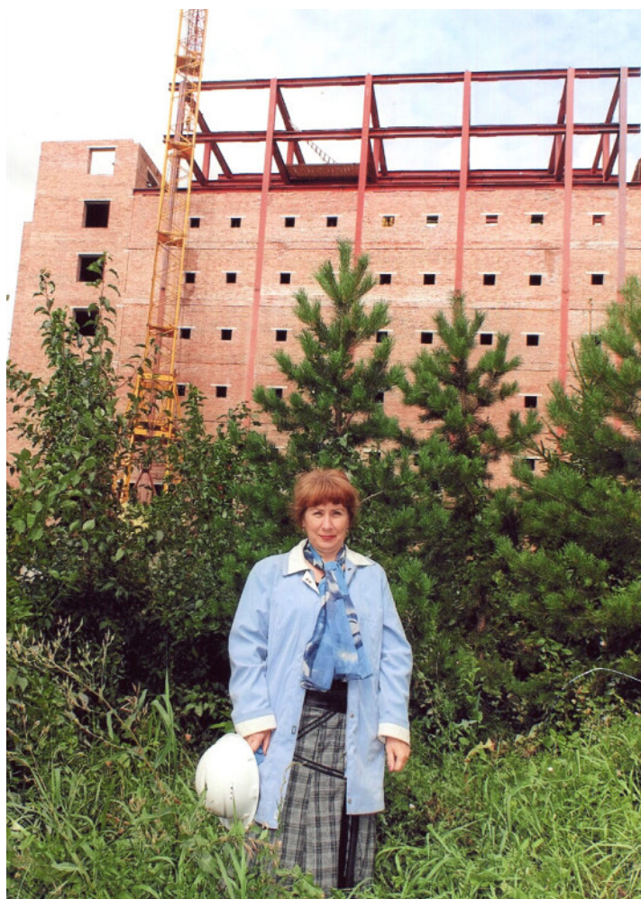
Г. Ю. Бородина, начальник архивного управления у строящегося нового здания Исторического архива Омской области. 2005 г.
