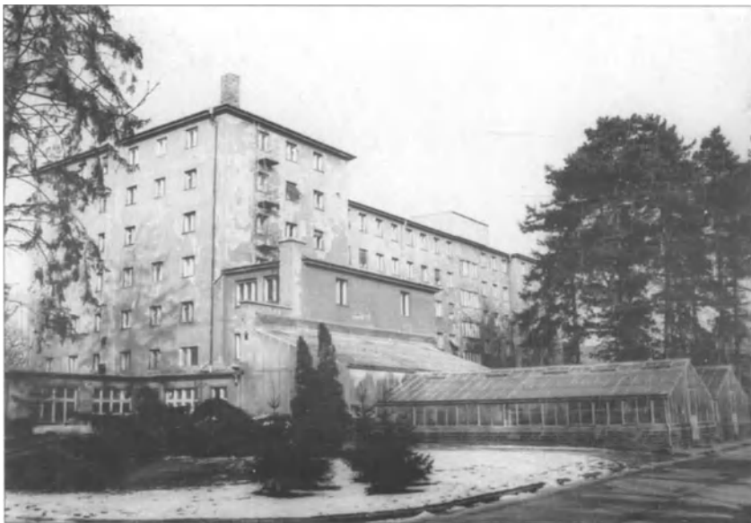
Abb. 12. Laborgebäude des Kaiser-Wilhelm-Instituts für Hirnforschung (heute Oskar- und Cécile-Vogt-Haus). Oben: Blick von Südost mit Hörsaal (links) und (Anbau dazu) Tierhaus für Affen; unten: Blick von Südwest mit genetischem Vivarium.
