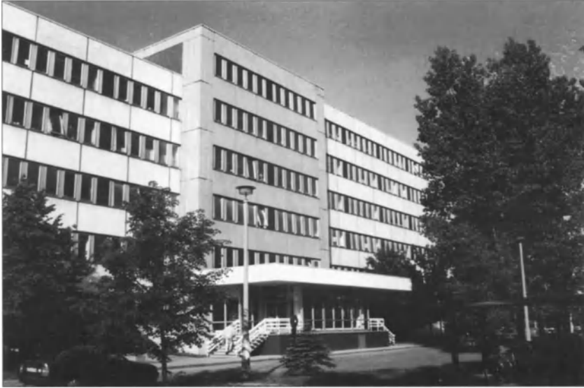
Abb. 64. Laborgebäude des Zentralinstituts für Molekularbiologie, Baubeginn 1974, fertiggestellt 1980, jetzt Max-Delbrück-Haus.
