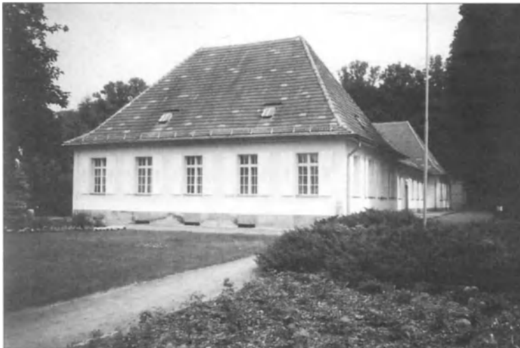
Abb. 4. „Wirtschaftsgebäude“ des ehemaligen Zentralfriedhofs Buch-Karow (s. auch Abb. 9), gebaut nach Plänen von Ludwig Hoffmann.
