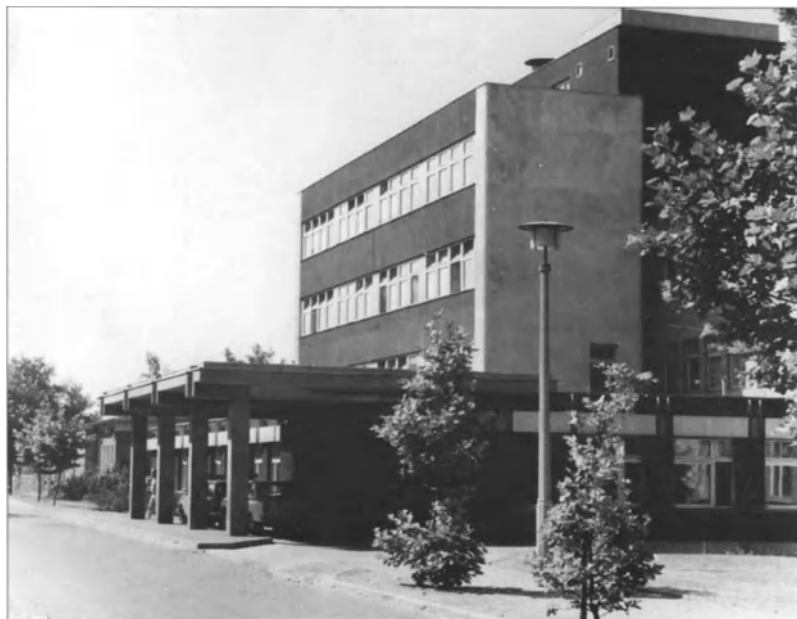
Abb. 69. Poliklinik der Robert-Rössle-Klinik am Lindenberger Weg, fertiggestellt 1980.
