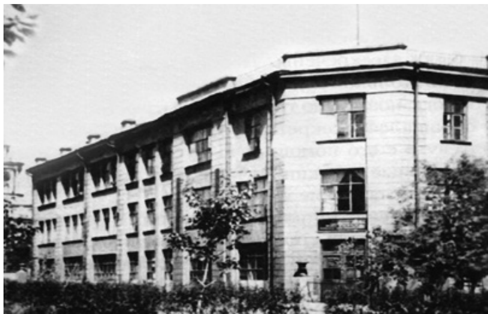
Банковский переулок, дом № 7. Здесь был Эвакогоспиталь № 1705, затем Институт ВОСХИТО, а теперь УНИИТО им. В. Д. Чаклина — организатора этого института в 1931 году. На здании есть мемориальная доска о госпитале, а внутри — экспозиция, посвященная госпиталю и истории Института.
