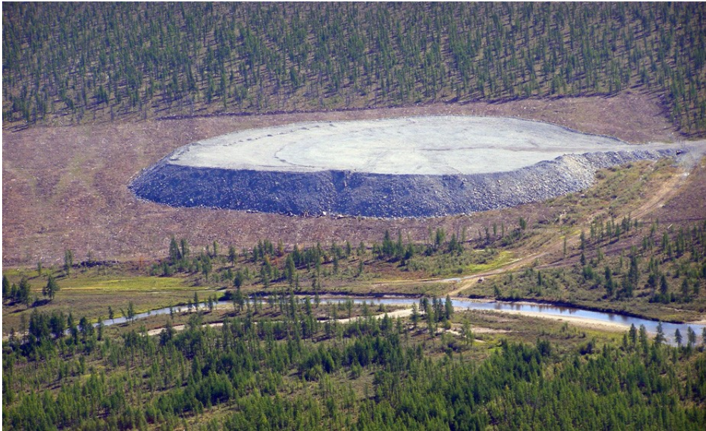
Рис. 3.17. Глыбово-щебнистая насыпь, перекрывающая навал, возникший на эпицентре взрыва «Кристалл». Подъездная дорога примыкает к южной стороне насыпи. На переднем плане ручей Улахан-Бысыттах. Фотография сделана с вертолѐта в 2007 г. (автор Захаров В. Е.)
