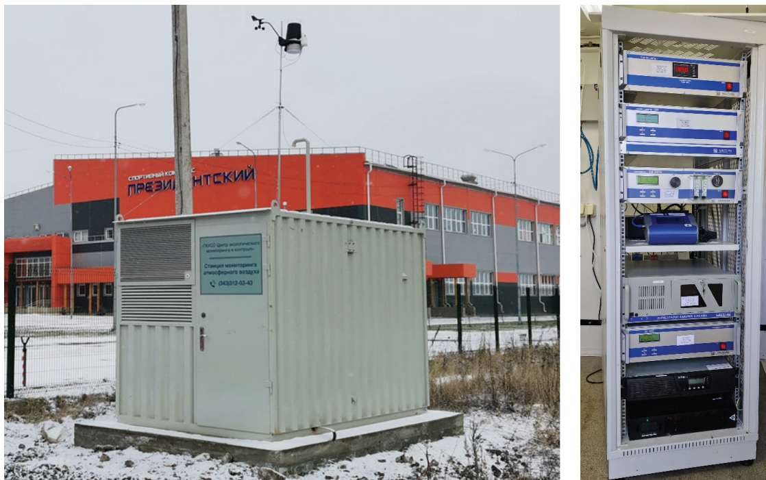
Рис. 6.5.2. Внешний вид и внутреннее оснащение автоматической станции контроля за загрязнением атмосферного воздуха в городе Нижнем Тагиле (пр. Уральский, 65а)
