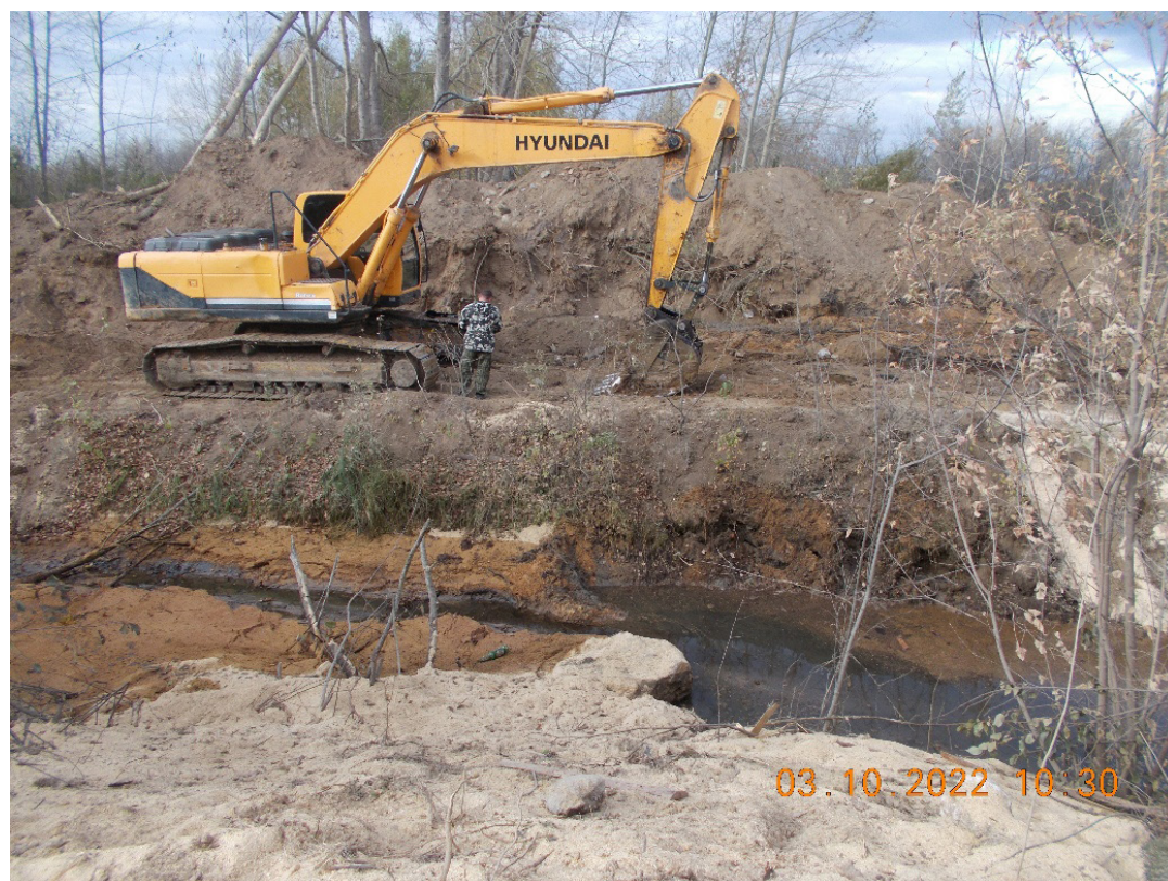
Рис. 4.4.2. Выемка опила из воды при помощи экскаватора
