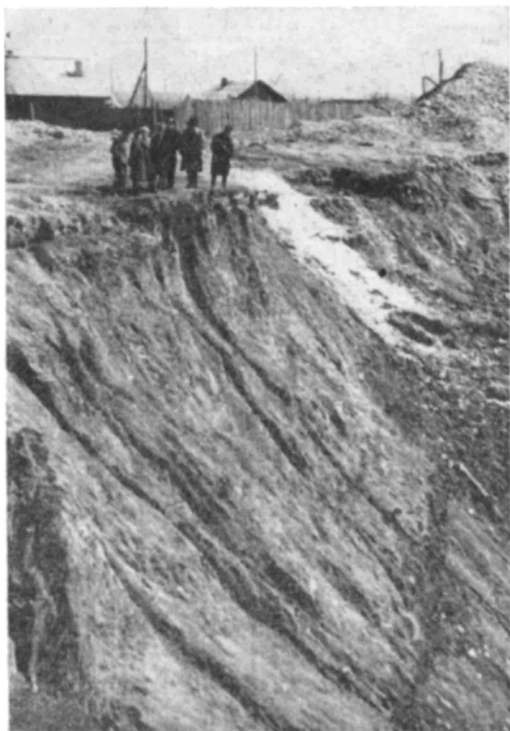
Рис. 1. Участок зоны обрушения.
