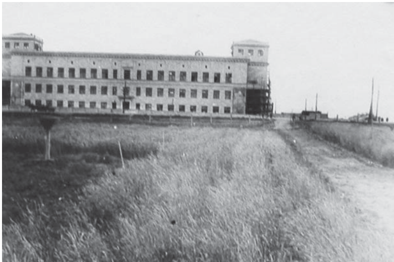
Здание Института генетики АН СССР на Каширском шоссе. Москва, 1934 г.
